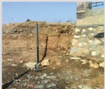
厂区西面围栏最北端(二期组件成品打包间北面),工程部在施工建设栅栏时留下了一个约1米宽的间隙。常有厂内人员为图方便在此进出,也有外来人员从此入口进入厂区捡拾废弃物,不利于厂区内部管理存在一定的隐患。
