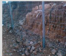
厂区西面围栏(对应电池二期与组件二期中间通道的位置)由于雨水冲刷导致土石塌方使得此处栅栏破损,易成为外部人员进入我厂区的一个通道,不利于厂区内部管理存在一定的隐患。
