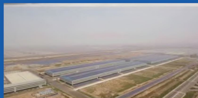
国电投鲁丽40MW屋顶分布式项目
