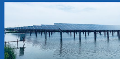
安徽铜陵110MW水面光伏电站项目
