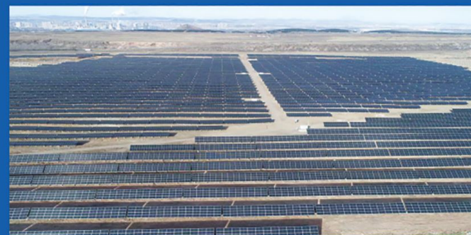
辽宁阜新45MW光伏电站项目
