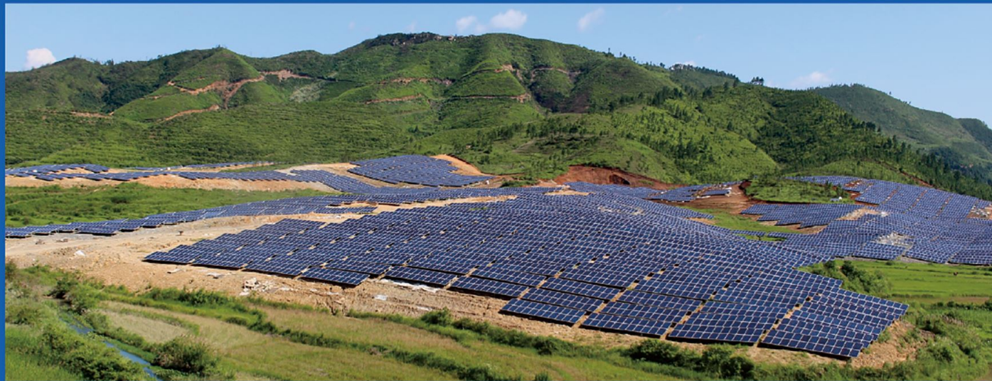
中节能江西莲花50MW光伏并网发电项目
