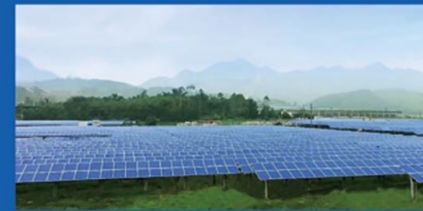
阳光电源仁化土壤修复60MW项目
