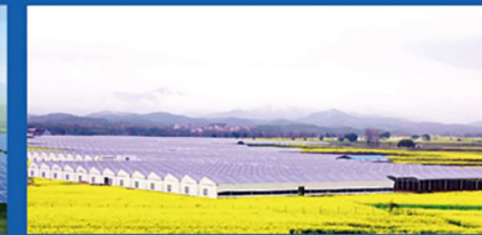
乐平20MW农业大棚光伏项目
