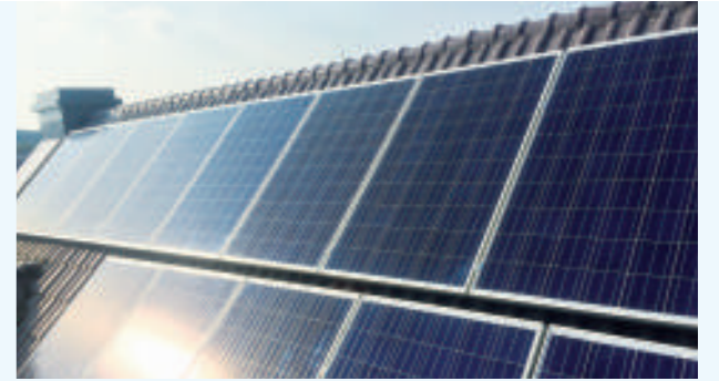
天福花园5KWp家用分布式光伏电站
