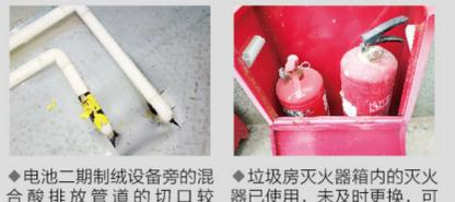
◆垃圾房灭火器箱内的灭火器已使用，未及时更换，可能影响火灾的扑救的速度！
