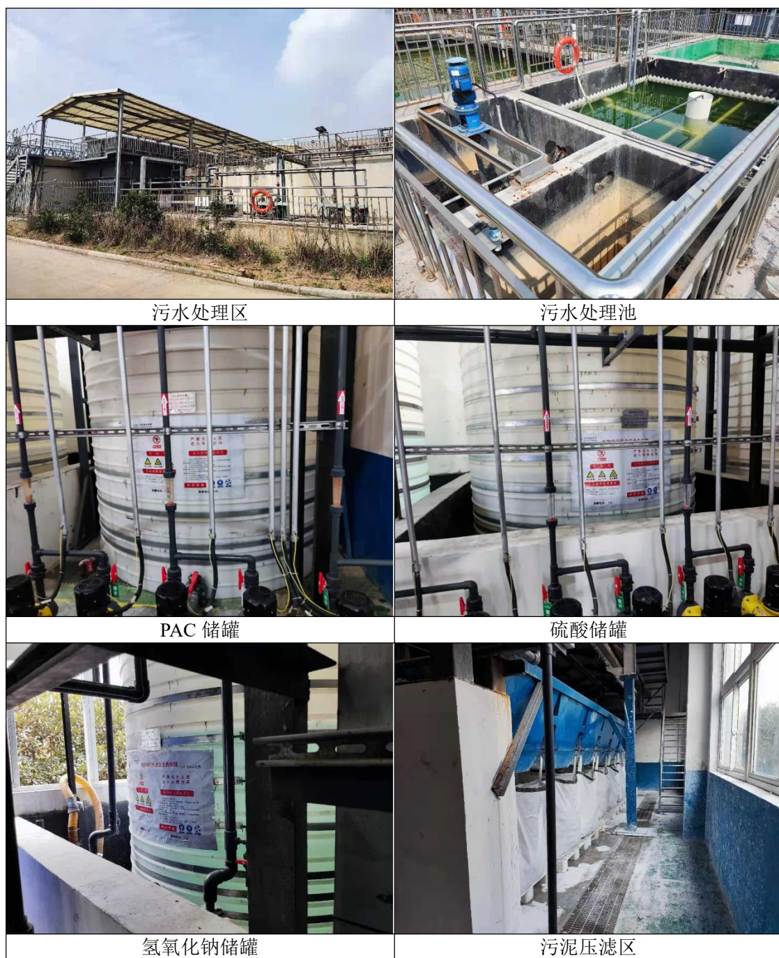
图 5.1-5 污水处理站踏勘图
