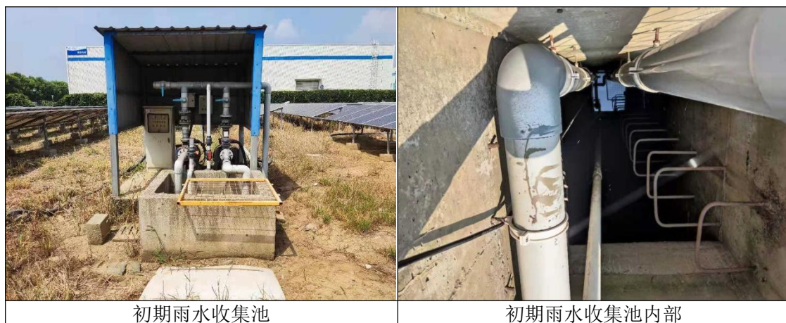
图 5.1-6 初期雨水收集池踏勘图
