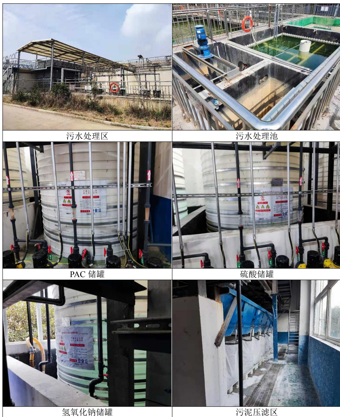
图 5.1-5 污水处理站踏勘图
