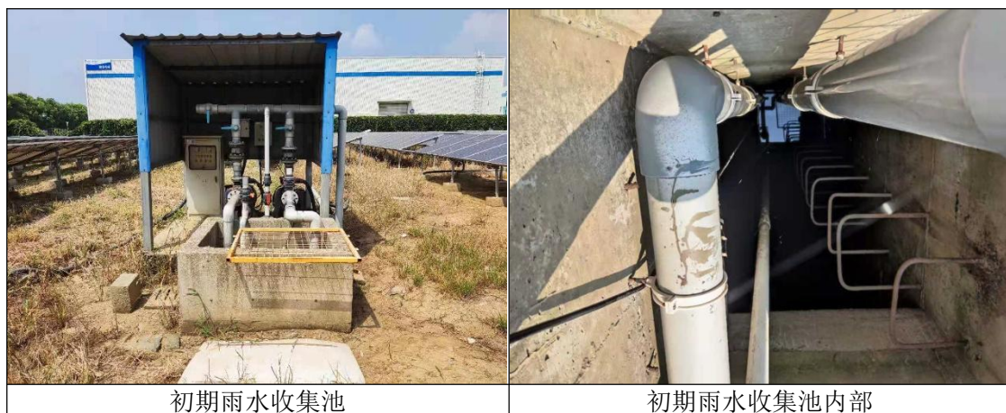
图 5.1-6 初期雨水收集池踏勘图
