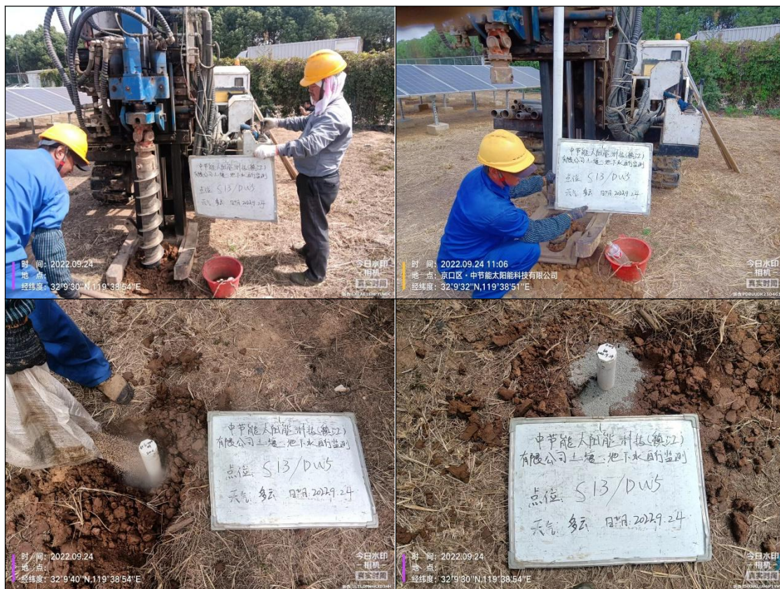
图7.2-1 地下水建井照片
