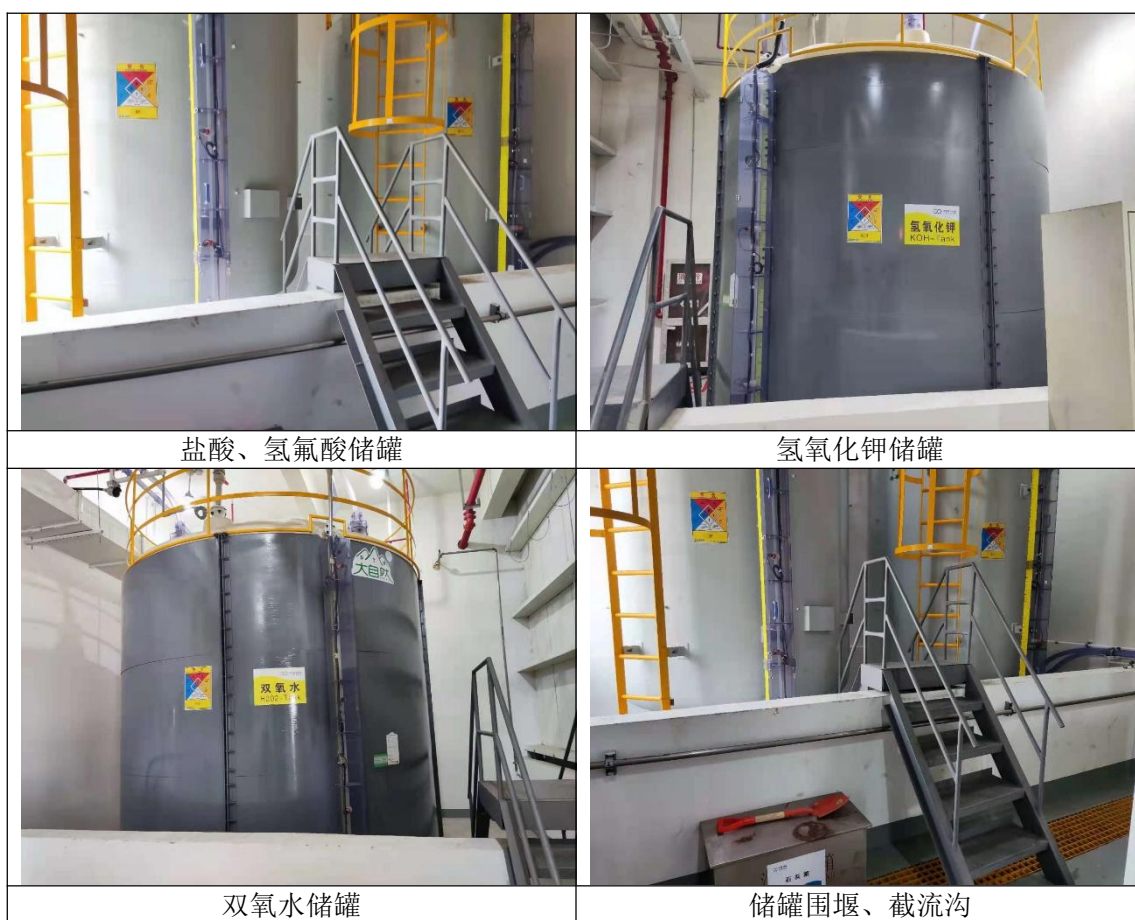
图 5.1-2 C1、C2 车间储罐踏勘图
