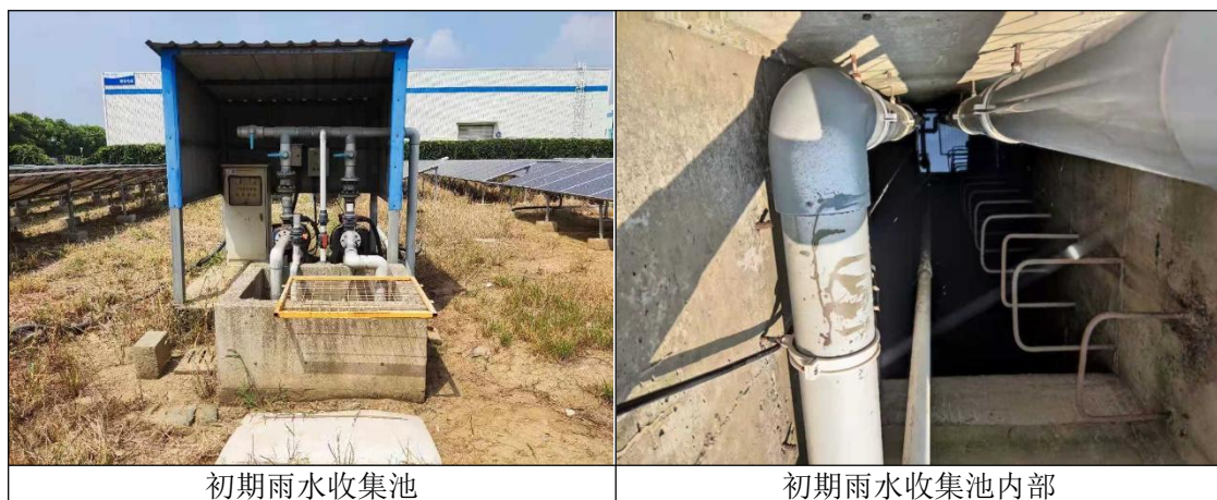
图 5.1-5 初期雨水收集池踏勘图
