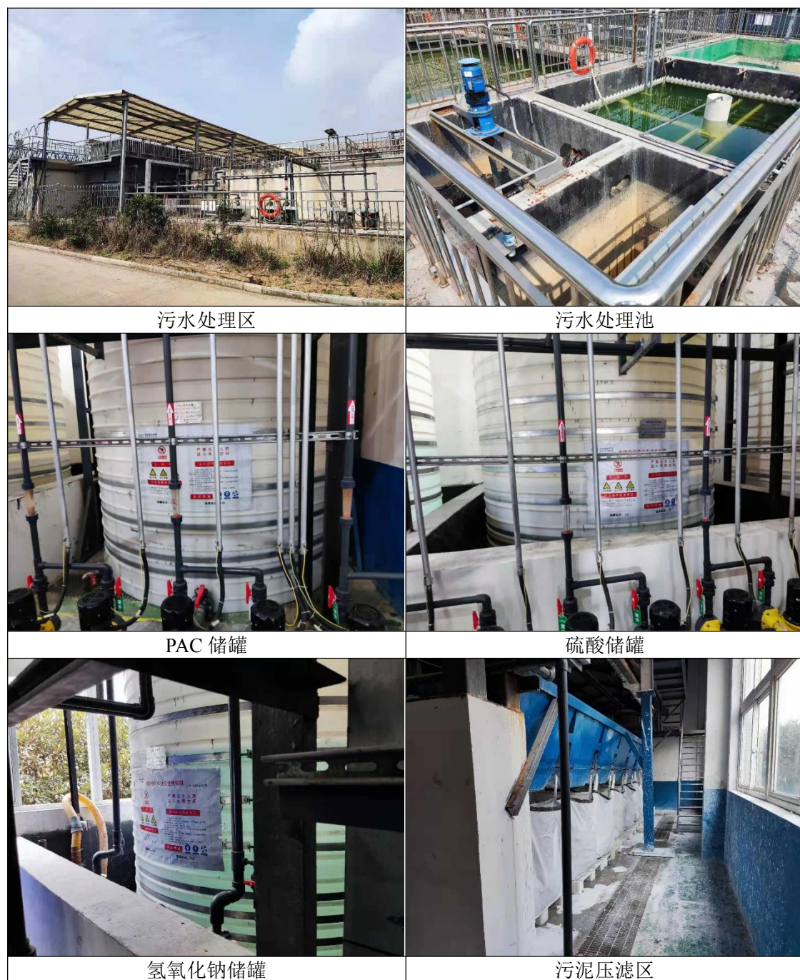
图 5.1-5 污水处理站踏勘图
